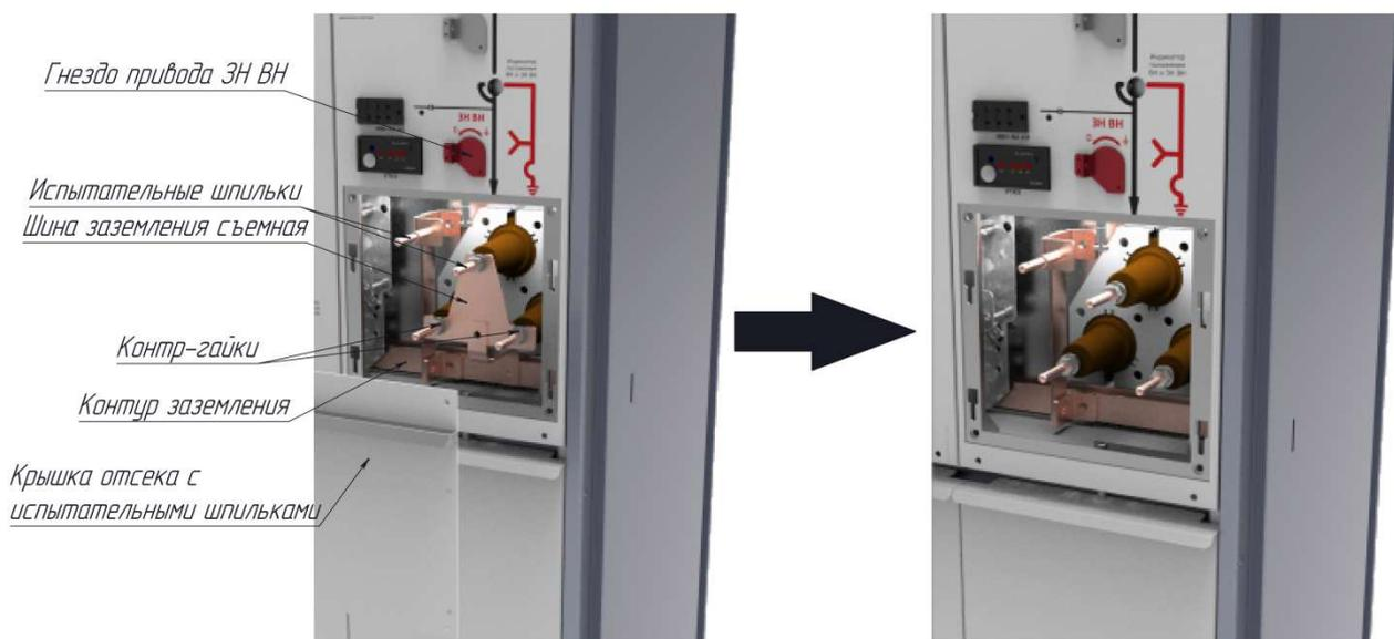
Рисунок 40. Узел с испытательными пальцами
