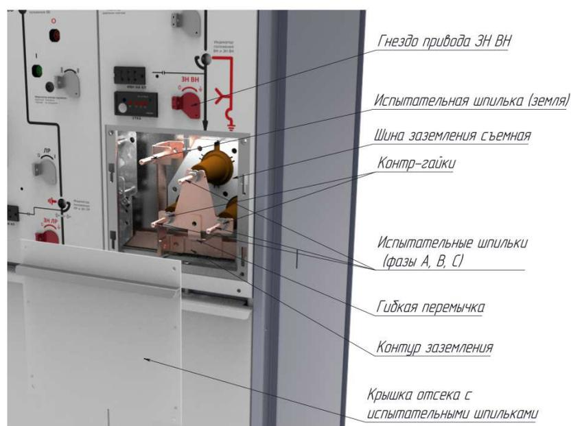
Рисунок 5. Узел испытательных втулок с установленной шиной заземления
