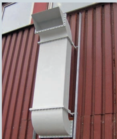
Пример контактного вывода за пределы помещения станции
