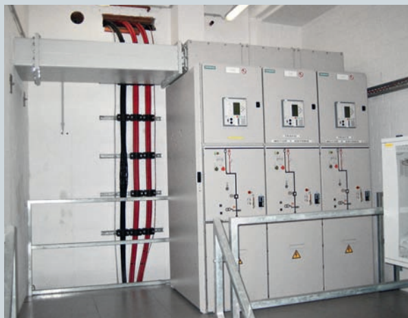
Пример контактного вывода за пределы помещения станции
