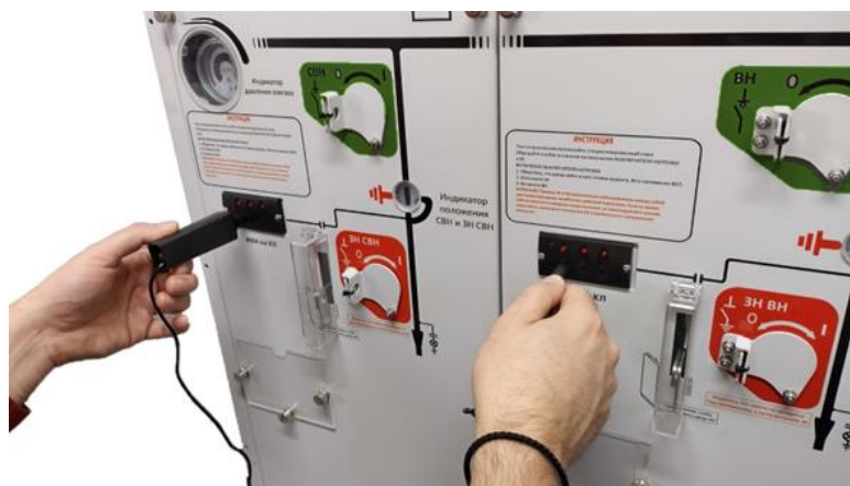
Рис. 5.6 Проведение фазировки
