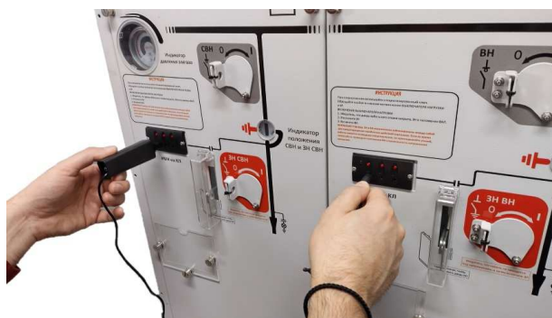
Рис. 8.3 Проведение фазировки
