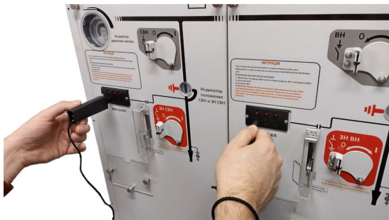
Рисунок 30. Проведение фазировки
