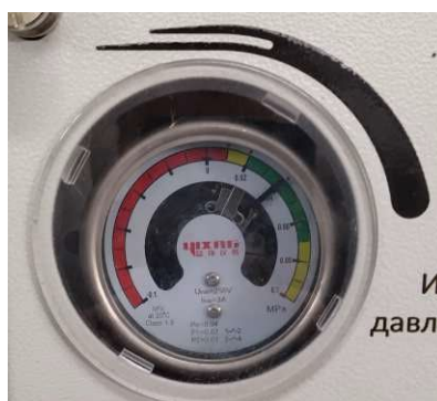
Рисунок 8. Индикатор давления элегаза
