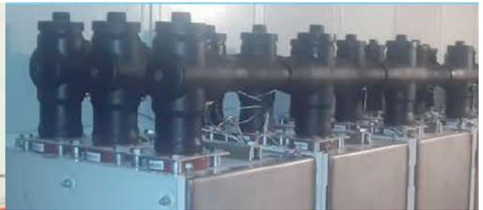
Соединение модулей сборными шинами на ток до 1250
