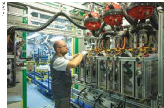
Зона испытания RM6
