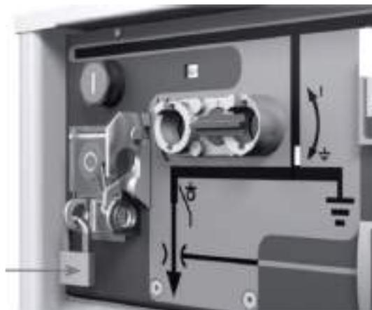
Рис. 4-14. Навесной замок на кнопке ОТКЛ.
