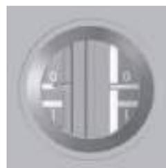
Рис. 4-8. Разъединитель-заземлитель в положении «шины»
