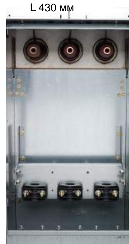
Состояние перед монтажом
