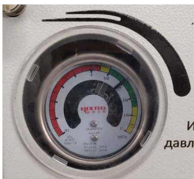
Рисунок 8. Индикатор давления элегаза
