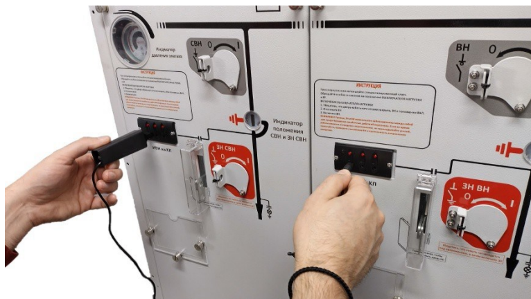
Рисунок 30. Проведение фазировки
