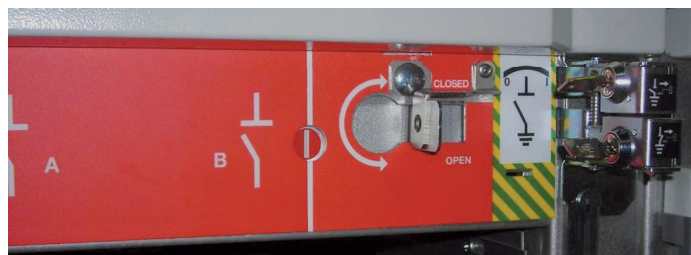
Рисунок 67. Отсеки исполнения с двумя системами сборных шин
