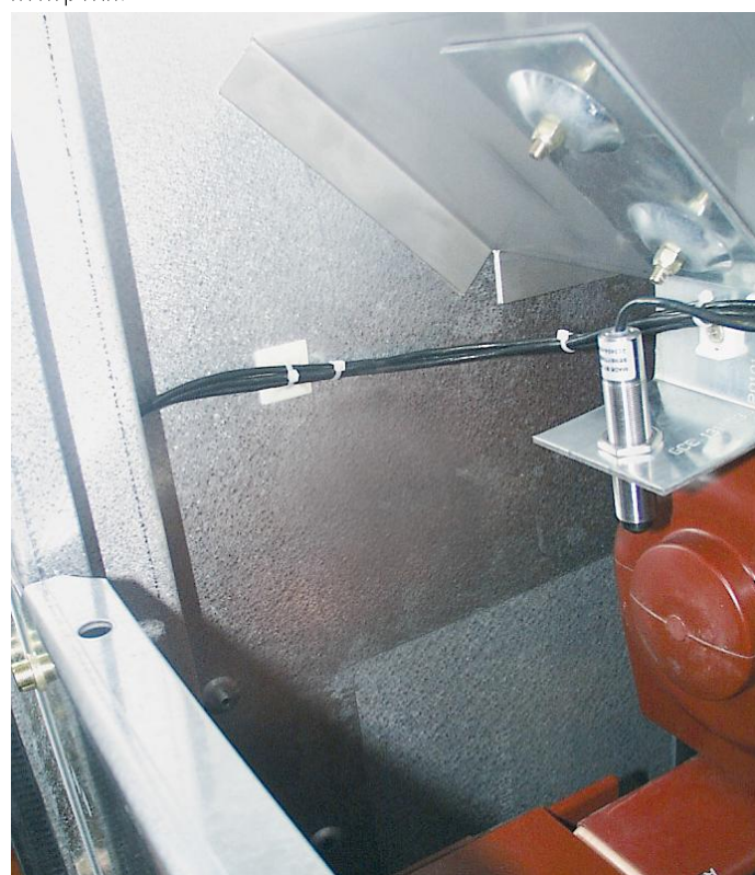
Рисунок 72. Пример термографической проверки UniGear ZS1 одноуровневого исполнения
