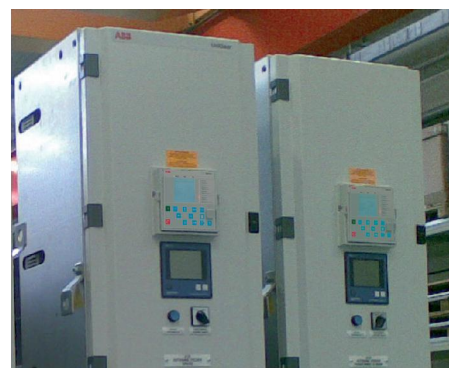
Рисунок 62. Пример UniGear ZS1 с высоким отсеком низкого напряжения (1100 мм)
