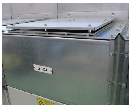
Рисунок 60. Пример распределительного устройства с компактным газовым каналом с выпуском газа через верхние дымоходные трубы (общая высота распределительного устройства составляет 2530 мм для 12–17,5 кВ до 40 кА)
