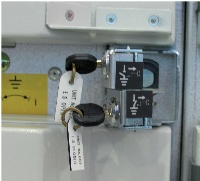
Рисунок 6. Двойной замок с ключом на заземлителе
