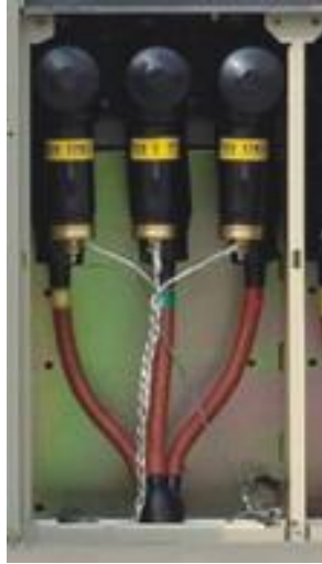
Рис. 14 Установка кабелей в кабельном отсеке
