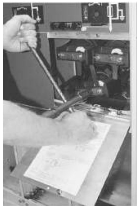
8. Поверните рукоятку на крышке предохранителя по часовой стрелке, чтобы закрыть и загерметизировать контейнер предохранителя. Используйте рукоятку.
