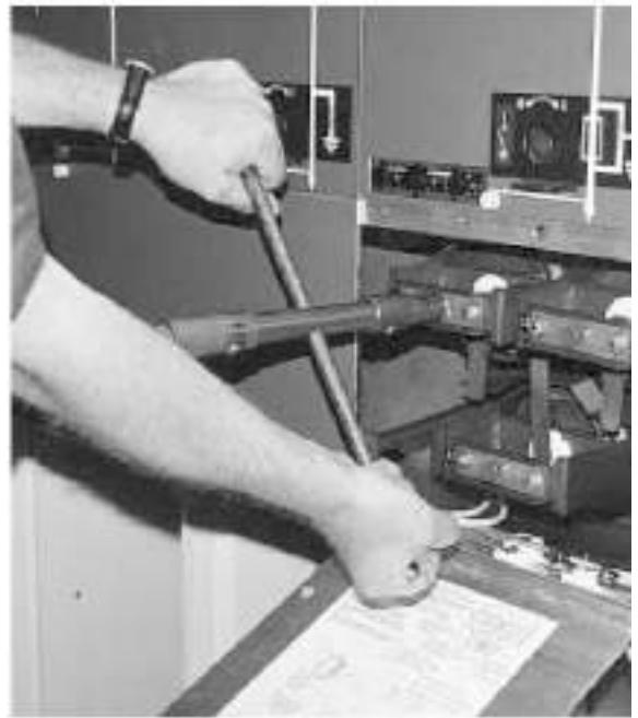
5. Приложив приводную рукоятку и, повернув её против часовой стрелки, открываем контейнеры для предохранителей
