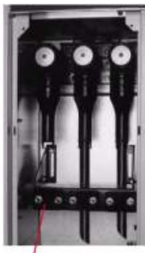
Регулируемая балка для крепления кабелей (опционно)
