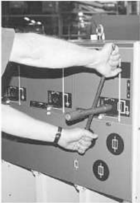
2. Включить заземлитель поворотом приводной рукоятки по часовой стрелке.
